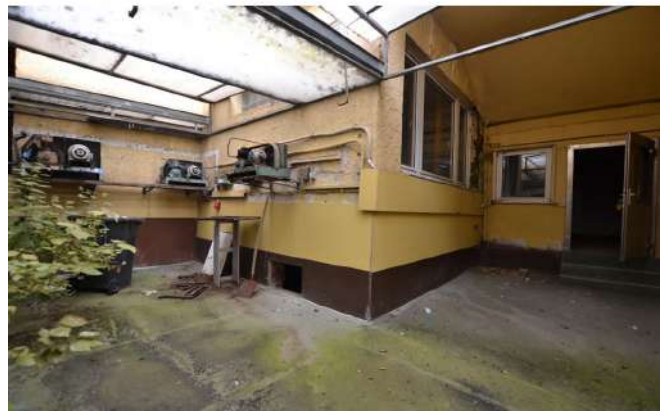
02. Eingang Hinterhof zur GE
